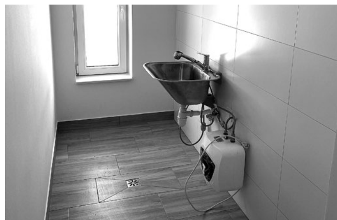
Wyremontowane jedno z pomieszczeń w świetlicy
