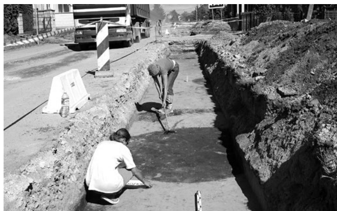
6. Obiekty w trakcie eksploatacji
