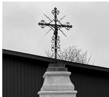
Po przeprowadzonych pracach konserwatorskich zabytkowy postument z ozdobnym, metalowym krzyżem i figurą Chrystusa odzyskał pełnię walorów estetycznych
