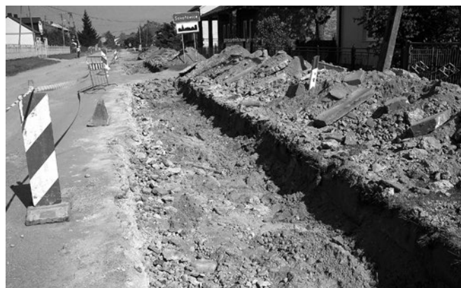
2. Widok na ulicę z wykopem pod kanalizację
