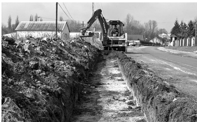
3. Widok drogi i wykop
